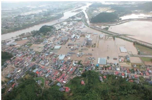
宮城県丸森町の浸水被害の状況 (山形県消防防災航空隊提供)
