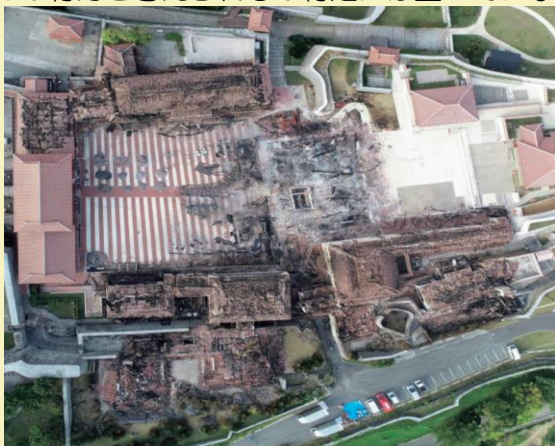
建物焼損状況（那覇市消防局提供）
