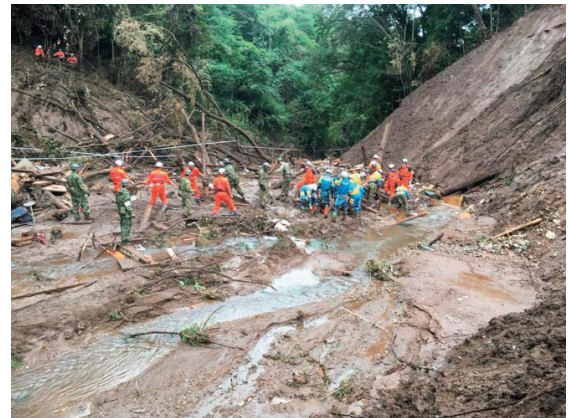
家屋の材料が堆積した場所における捜索の状況。谷間の活動で上流と斜面の両方に注意が必要であった。写真左上に監視員が3人見える（相模原市）。
