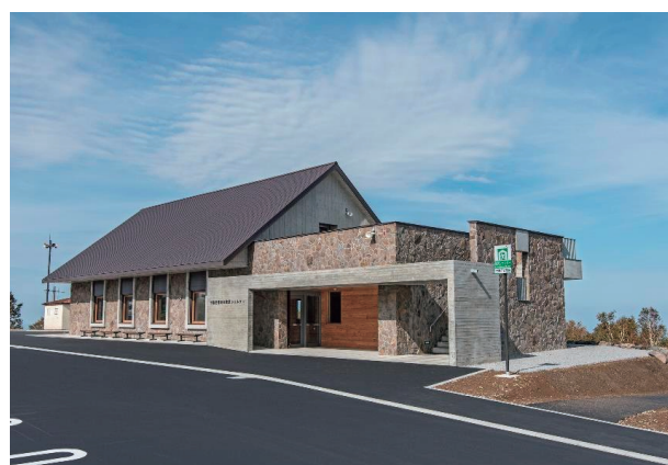
美瑛町の退避舎（十勝岳望岳台防災シェルター） （美瑛町提供）
