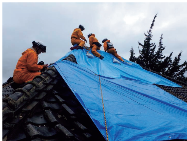
ブルーシートによる家屋の応急補修活動 (習志野市消防本部提供)
