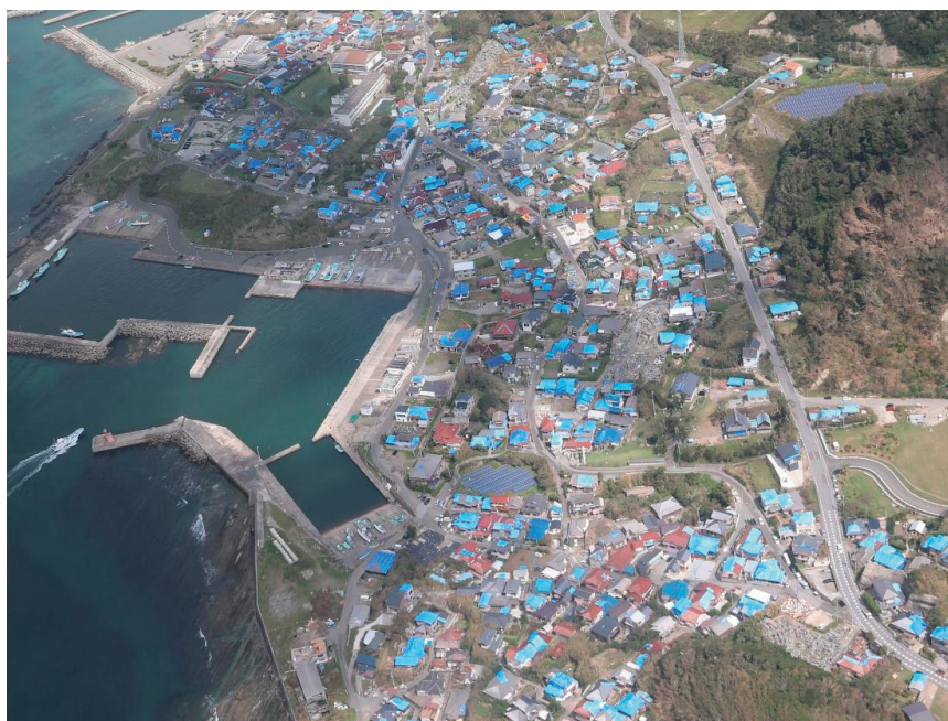
強風により屋根瓦が飛散した千葉県館山市の状況
